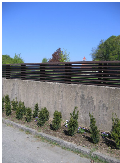
Del av muren intill huvudentrén
