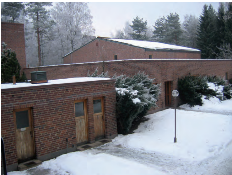
Stolpbelysningen närmast kapellet före åtgärd. Foto: JLM, Jonas Haas januari 2006.
