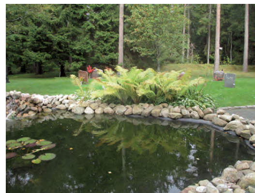
Hela dammen inramas av natursten, gångvägen som är belagd med stenmjöl avgränsas av storgatsten.
