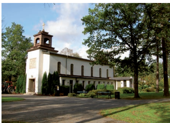
Skogslyckans kyrka uppfördes 1943 som begravningskapell, men efter en genomgripande ombyggnad 1966 invigdes den till kyrka.
